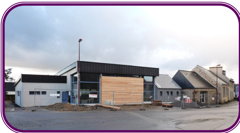
Salle multifonctions en construction, mars 2014
