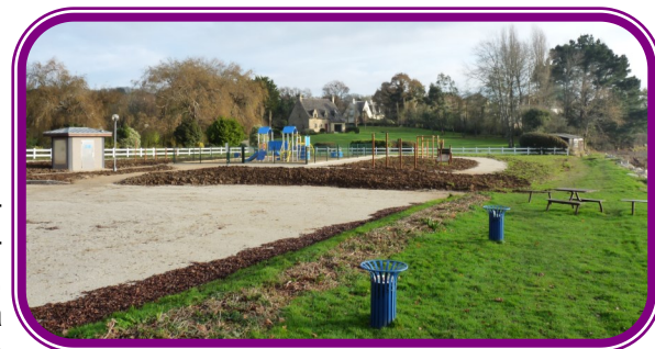
Le chantier de Lanvoy
