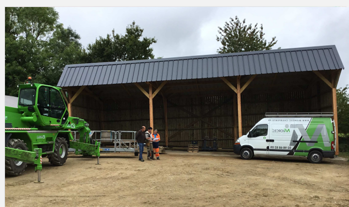
Construction d'un carport aux services techniques
