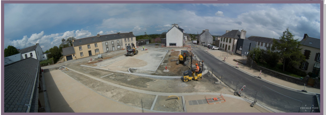
Photo grand angle prise du toit du centre de loisirs Crédit photo : https://www.facebook.com/focalefixebrest
